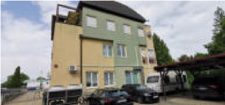
Mehrparteienhaus in 2130 Mistelbach
