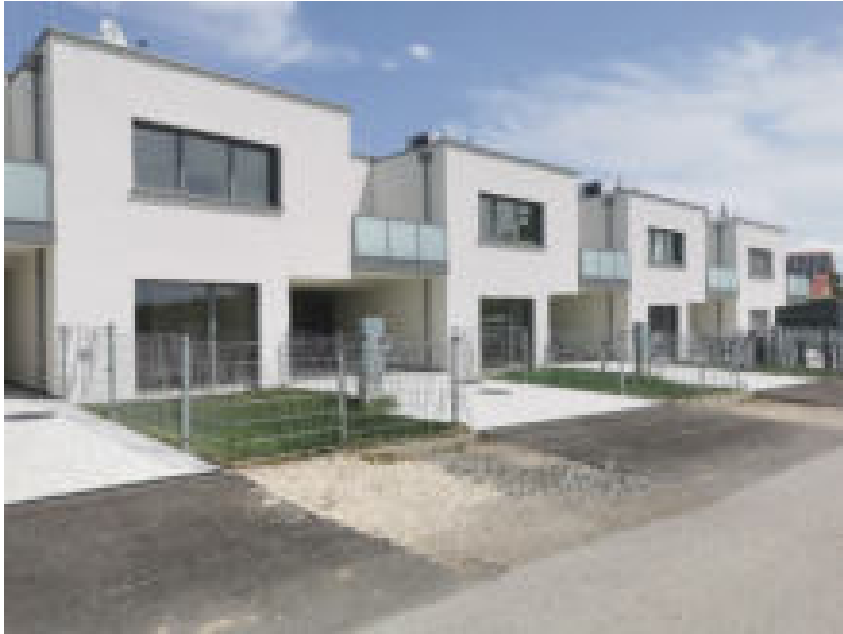
Reihenhausanlage in 2120 Wolkersdorf
